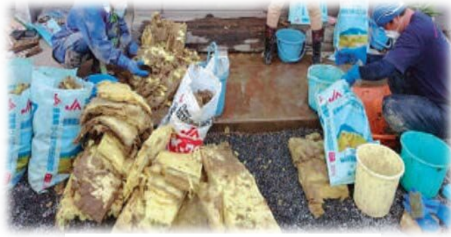
浸水したグラスウール
