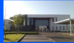
三瀬生涯学習センター (令和7年度竣工)
