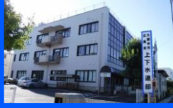
上下水道部合川庁舎 (令和3年度竣工)
