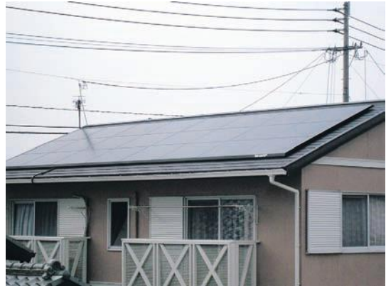
太陽光発電システム
