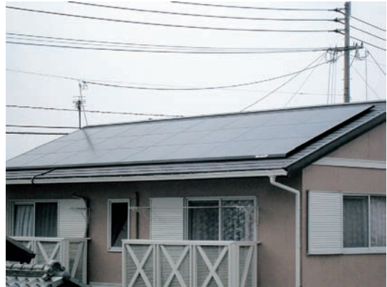
太陽光発電システム
