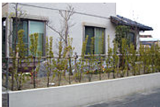
設置された生け垣
