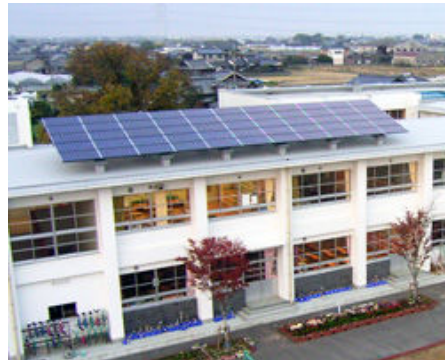
青木小学校に設置された太陽光発電パネル
