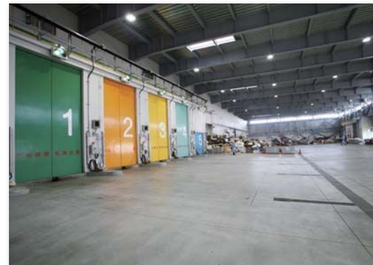
宮ノ陣クリーンセンターのプラットホーム
