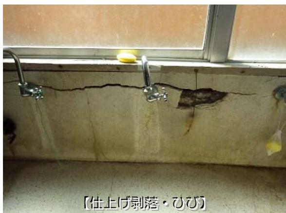
廊下、理科室、家庭科室、図工室などに設置されている流し台の劣化が進んでいます。流し台の側面や底面にひびが入っています。
