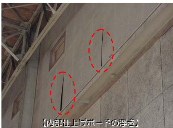
非構造部材である仕上材が大地震時に落下する事例が、全国で報告されています。
