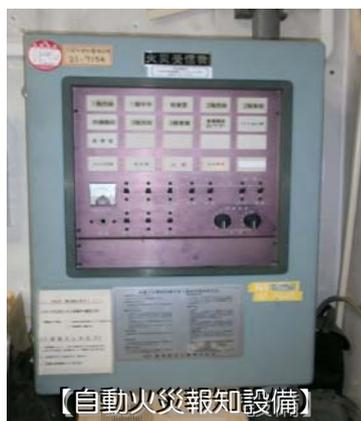
火災発生を建物内に知らせる設備です。火災による熱や煙を感知器ですばやく検知し、受信機、音響装置（ベル）を鳴動させることで、初期避難と初期消火活動を促します。故障すれば避難が遅れ、人的被害を発生させる恐れがあります。
