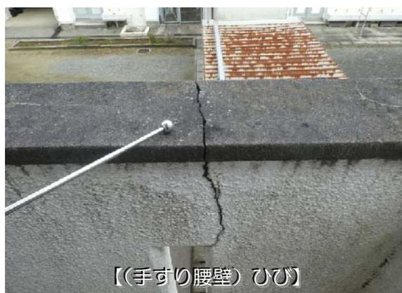
外壁の劣化が進みひび割れが生じると、外壁や柱などの構造体に雨が入り込んでしまいます。その結果、コンクリート内部の鉄筋がさび始め、そのさびが進行するとさびの膨張によりコンクリートやモルタルを破壊する「爆裂」現象を引き起こします。爆裂はコンクリートやモルタル片を落下させることもあり危険です。
