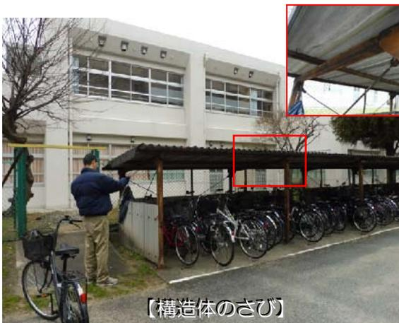
構造体である鉄骨のさびが進行しています。また、屋根材が破損し雨が漏っている部分もあります。
