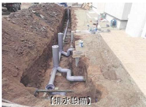
排水管が老朽化すると、管の亀裂や固着物の蓄積が発生し、汚水漏れ、詰まり、逆流等が発生し、学校運営に支障をきたすと同時に、衛生的な環境を保てない状況となります。
