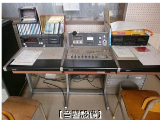
学校の音響設備は、音声、音楽、チャイム等の日常的な校内放送だけでなく、ヒアリングテストの音声や入学式・卒業式・運動会などの学校行事にも必要な設備です。また、火災や地震時の緊急放送など、安全管理上において重要な設備です。
