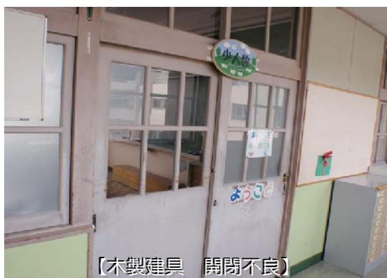
未だ多くの校舎で、間仕切り壁と建具が建築当時の木製のままとなっています。老朽化により、教室の出入口のドアの開閉や施錠に支障をきたしています。
