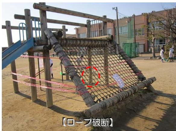
子どもたちが遊ぶ遊具は、定期的な点検を実施していますが、鉄部の腐食やロープの破断など、危険な箇所が増加しています。
