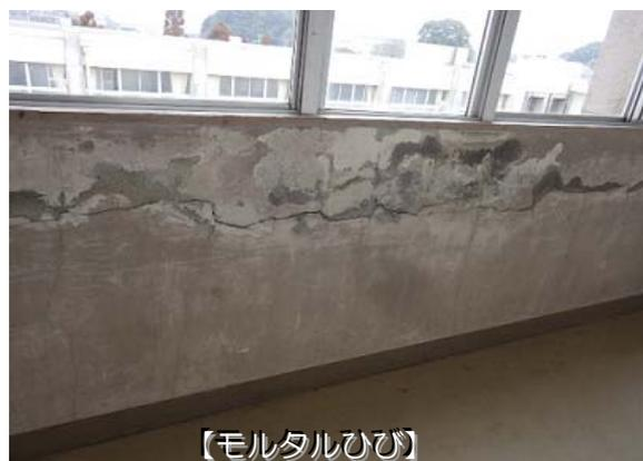
内壁のモルタル仕上材に、ひび割れが発生しています。
