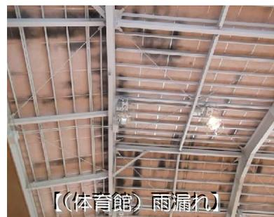
屋上防水の劣化が進むと、雨漏りが発生します。雨漏りは、カビの発生、電気設備の漏電、天井材の剥落を引き起こすだけでなく、屋根・床・柱・梁・壁などの構造体の劣化を急激に進めてしまいます。構造体は他の部分と異なり、一部だけ取り替えることは困難であるため、構造体の劣化は建物の寿命を縮めてしまうことになります。
