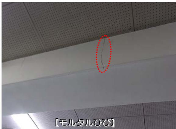
梁のモルタル仕上材にひび割れが発生しています。モルタル片の落下の危険性もあります。
