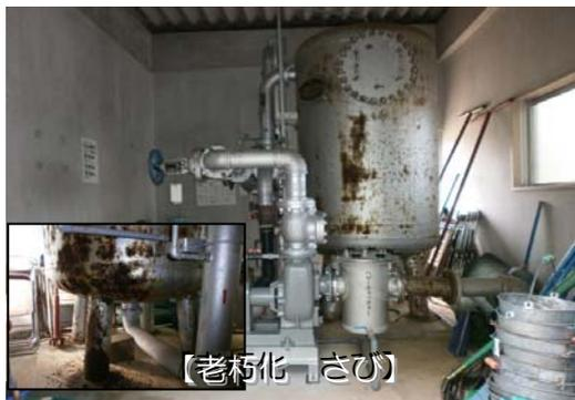
プールの水をろ過し、塩素を使って滅菌する設備です。この設備導入により、プールの水の入れ替えの回数が減り、水道代を必要最低限に抑えることができます。
