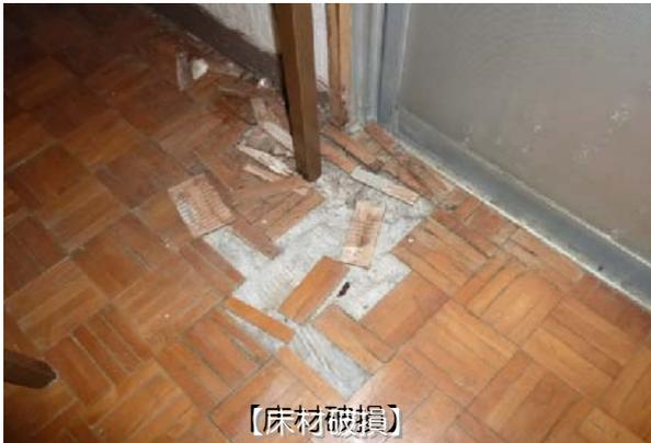
床材が剥がれて支障をきたすなど、床材の劣化が全体的に進んでいます。部分的な修繕ではなく、全面改修が必要です。
