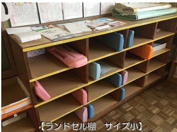
棚板が劣化し、穴やささくれがあります。また、最近の大型化したランドセルを古い校舎の棚に収納するにはサイズが合わず、ランドセルに擦り傷をつけてしまうことがあります。
