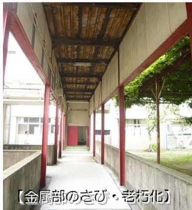
開放廊下は直接雨が当たるため、老朽化が進みやすく、鉄骨のさび止め塗装や外装材の改修が必要です。
