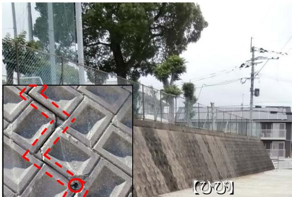
擁壁は、敷地に段差があるときに、土砂が崩れないように築いたものです。
