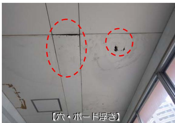
天井材が老朽化し、天井下地への固定が弱まっている可能性があります。特に雨漏れのある部分、劣化が著しく、天井材の落下の危険性もあります。
