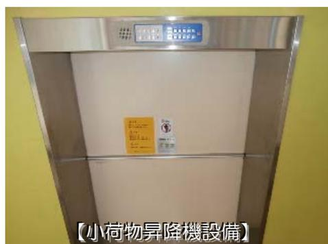
給食を1階の配膳室より上階へ運搬するための設備です。故障すれば、食材が運搬出来ないだけでなく、誤動作を起こす危険があります。
