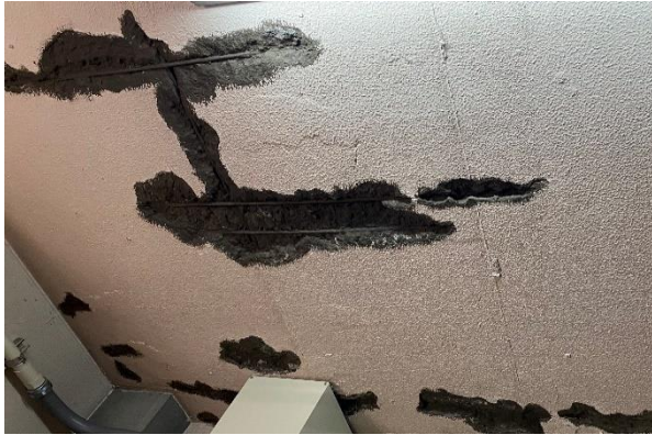
【無停電装置室】内部鉄筋が露出 (コンクリートが剥離し鉄筋が露出。強度的に不十分な状態)
