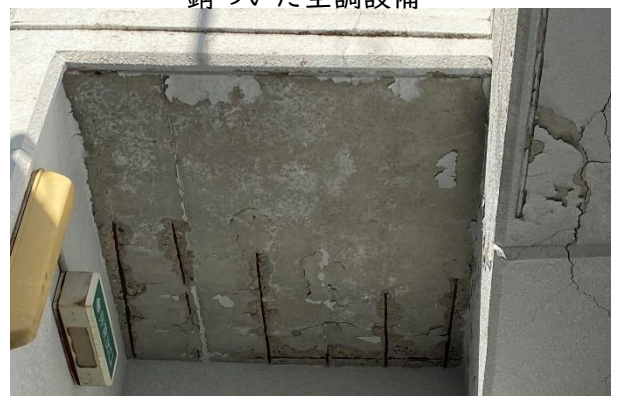
【メインスタンド外部廊下】内部鉄筋が露出 (雨水浸透のため鉄筋が錆びつき、コンクリートが剥離)
