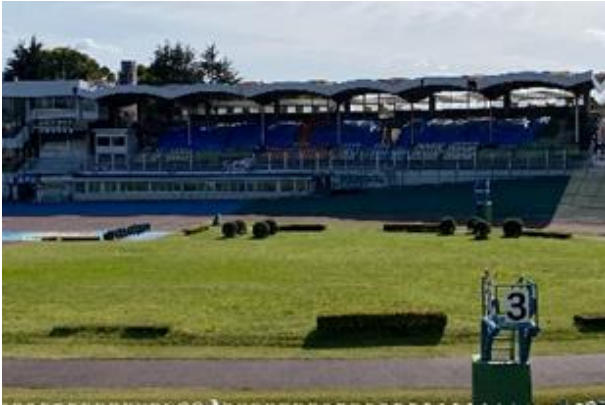
【メインスタンド】 耐震基準を満たしていないため閉鎖中
