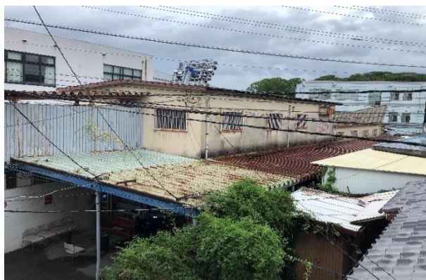
【旧集計センター】 錆びついたトタン屋根
