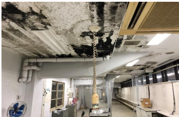
【メインスタンド地階】 漏水により天井破損
