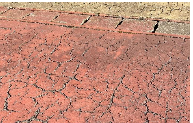
【正源氏プラザ】 ひび割れた舗装
