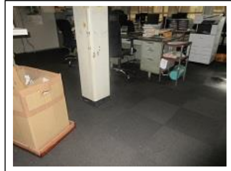
【右写真】直後の事務室内 【左写真】浸水の状況
