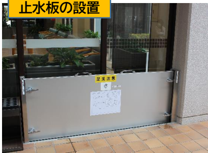
止水板の設置
