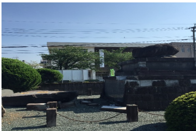
菊陽町役場前の壊れた慰霊塔
