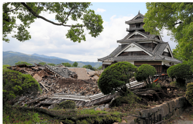
熊本城 平成28年4月14日、16日 2度にわたる地震で被災
