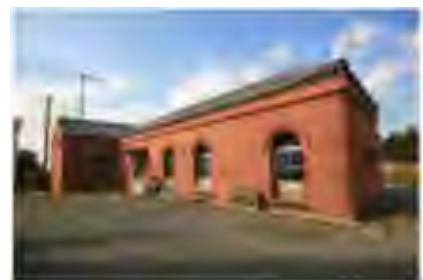
写真 旧三井寺ポンプ所及び変電所
