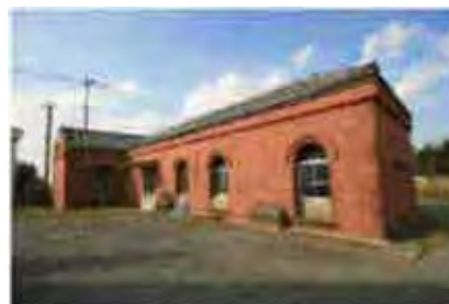
写真 旧三井寺ポンプ所及び変電所
