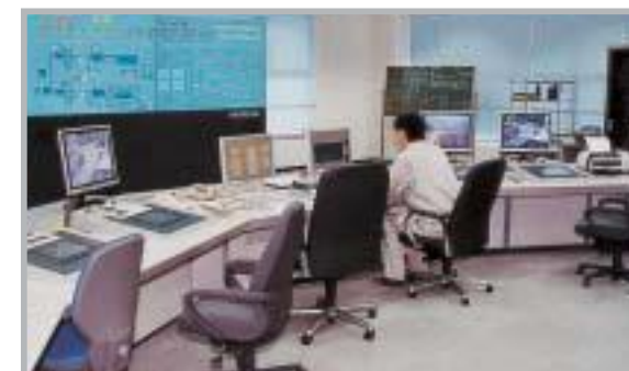
浄水場管理システム (浄水管理センター)
