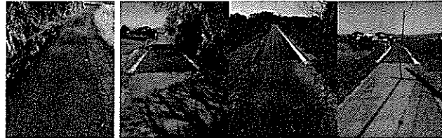
8. 城島町下田芦塚切通川・開平江川堤防修復工事
