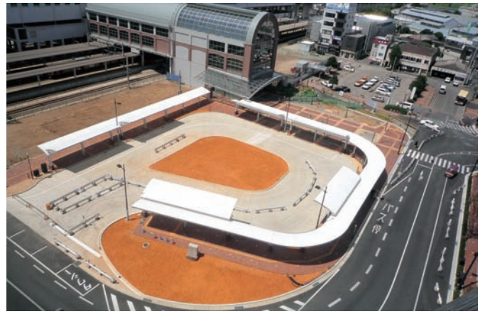
開業に向け整備が進むJR久留米駅
