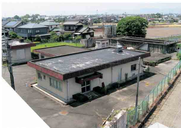
江上配水場跡地
