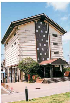
郷土の文化財等が保管されている「久留米文化財収蔵館」
