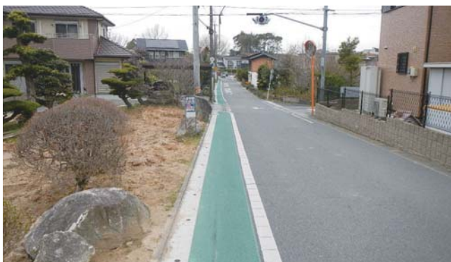
路側帯をカラー舗装した通学路
