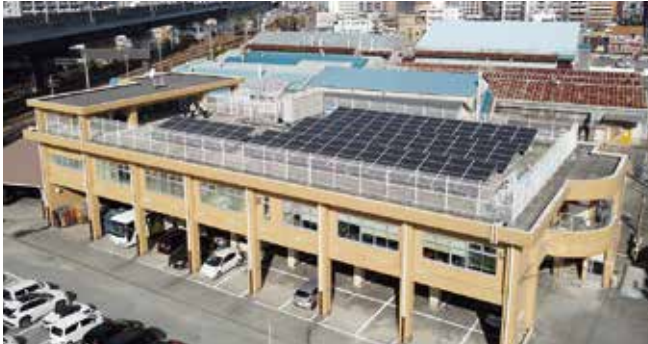
ZEB化認証を取得した環境部庁舎
