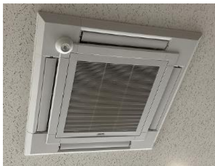
換気機能エアコン
