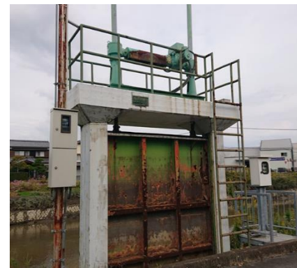
老朽化した樋門
