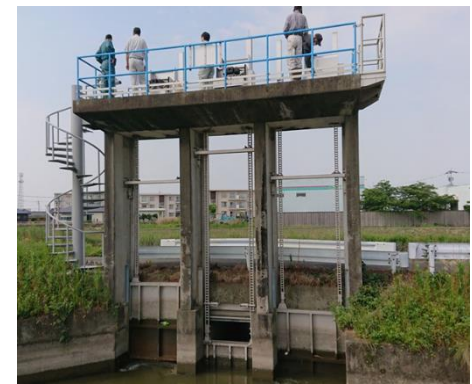
改修された樋門
