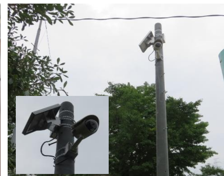
簡易監視カメラ設置(例)
