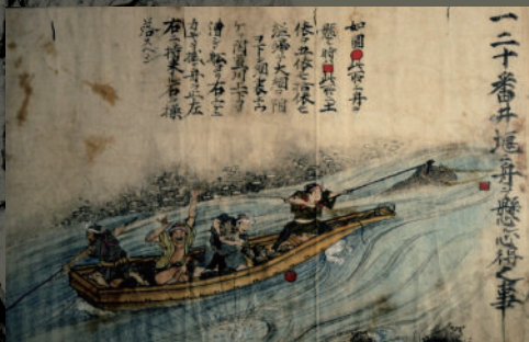
▲ 船をつなぎ一気に石を投げ入れる様子を描いた「床島堰築造絵図」。工事の心得、材木や石などの運搬の要領や器具の使い方が記されています
