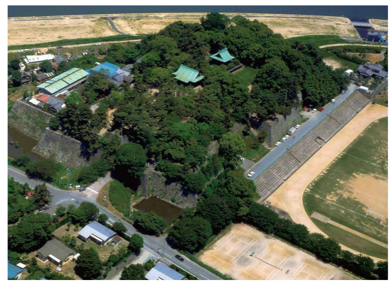
久留米城本丸全景 筑後川左岸の小高い丘の上に築かれている
