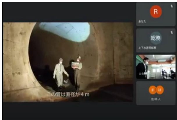
東櫛原貯留施設
