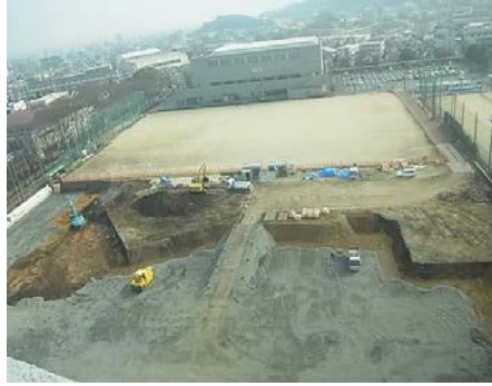
久留米大学貯留施設
