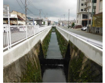
護岸のかさ上げ
