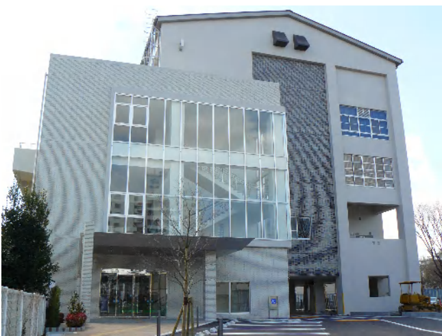
庄島体育館（23年3月竣工）
