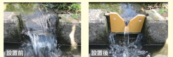
田んぼの排水口に V 字型の板などを設置して、水路に流れる水の量を減らしています
