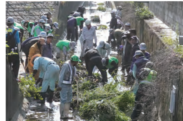
排水路の泥や草を取り除きました
