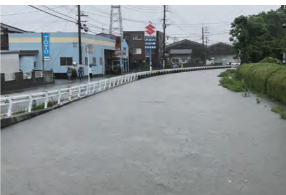
平成30年7月豪雨時、池町川の中央浄化センター付近
