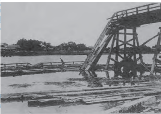
昭和28年の大洪水で崩壊して流される宮ノ陣橋
