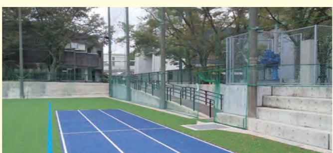
久留米大学と協働して整備した雨水貯留施設。地上から約2m掘ってグラウンドを整備し、21,800㎡の水をためられるようになりました
