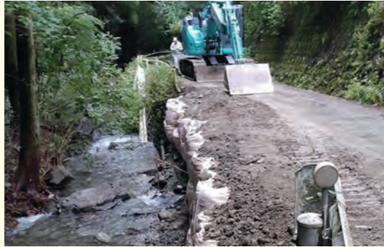
仮復旧工事中の市道
