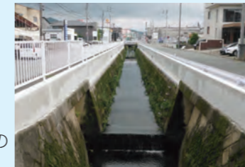
護岸かさ上げの実施例
