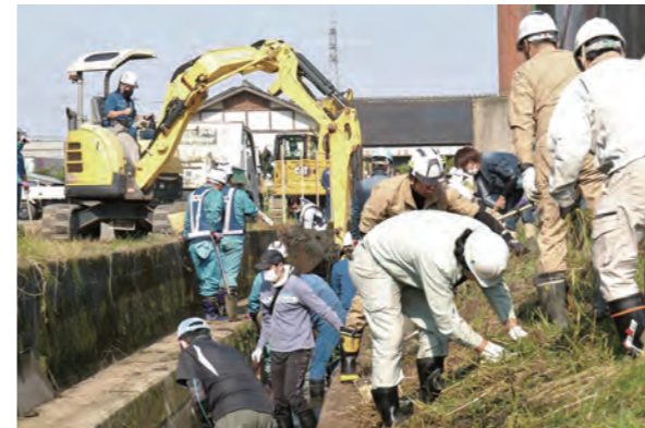
22日は、スコップや重機でたまった排水路の泥をかき出すしゅんせつ作業や除草を行いました
