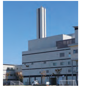
宮ノ陣クリーンセンター
