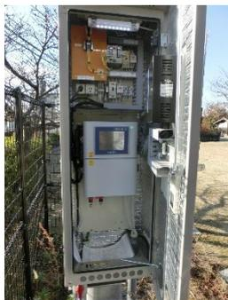
▲ 遠隔監視装置による残留塩素の測定
