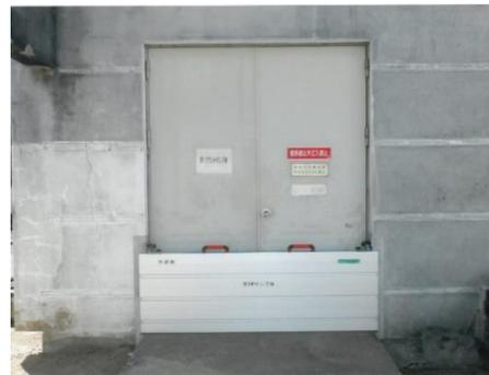
▲耐水化実施状況（止水板の設置）
