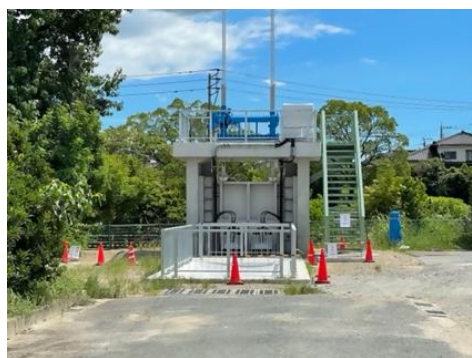
ゲートポンプ (R6.6 運用予定)
