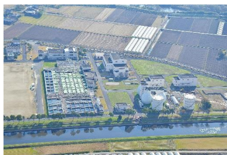
▲ 南部浄化センター
