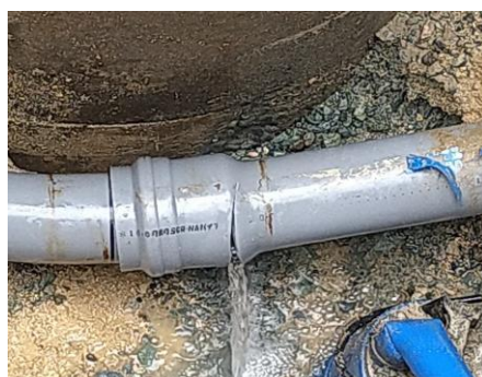
図 2-2-11 管路の破損や老朽化した構造物の様子
