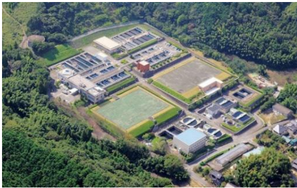
▲ 放光寺浄水場
