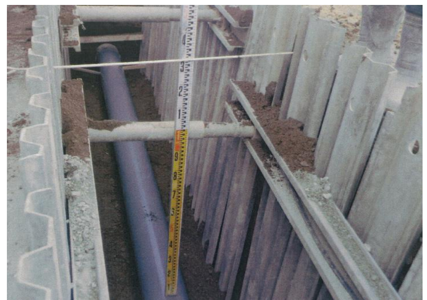
下水道管を布設する様子
