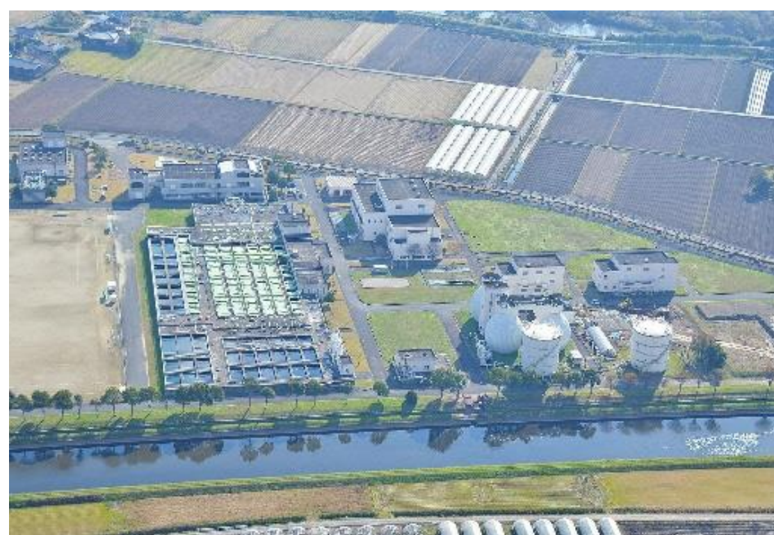
南部浄化センター
