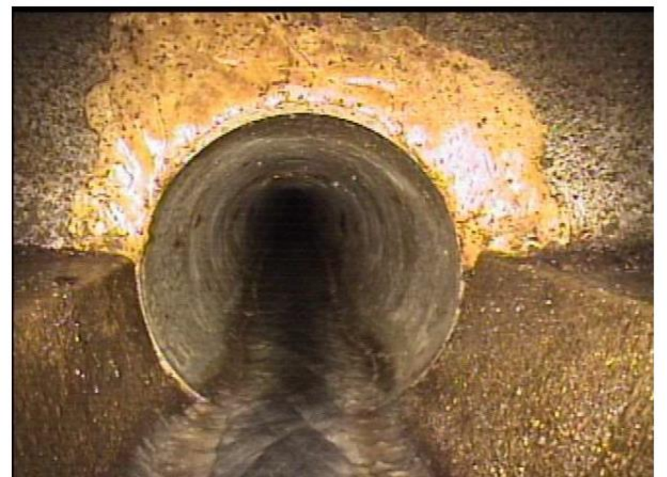
下水道管路内の様子
