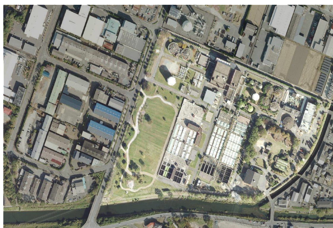
中央浄化センター
