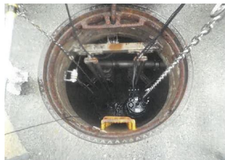
(マンホールポンプ場更新工事の様子)
