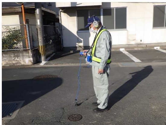
▲ 漏水調査の様子
