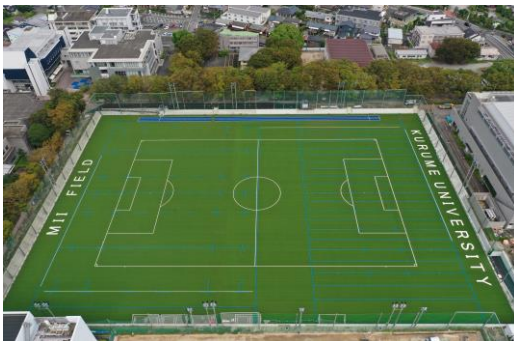
久留米大学雨水貯留施設 (R6.6 運用予定)
