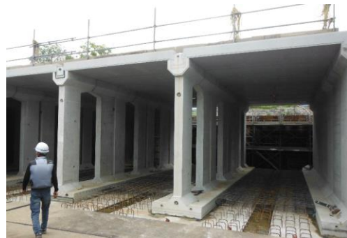
御幣島公園雨水貯留施設 (R6.6 運用予定)
