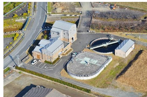
▲ 田主丸浄化センター
