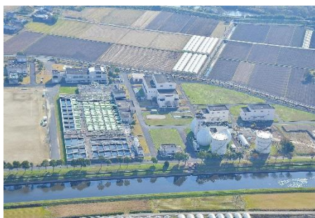
▲ 南部浄化センター
