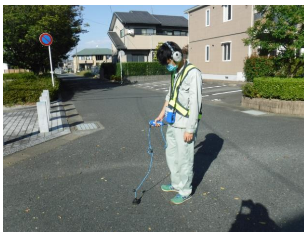
▲ 漏水調査の様子
