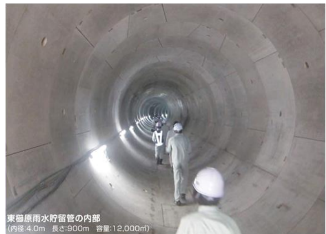
図3-1-10 東櫛原地区雨水貯留施設
