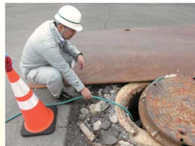
◀「下水道管を調査する様子」
