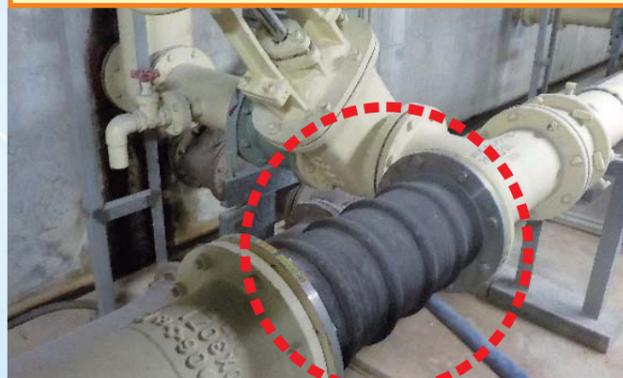
下水処理施設の配管の一部に、地震などの衝撃を吸収することができる「可とう管」を導入するなど、耐震化に取り組んでいます。
