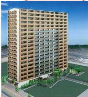
新世界地区優良建築物等整備事業 (民間分譲マンション)
