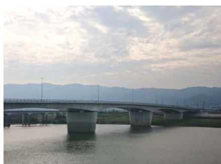
<(主)久留米筑紫野線 神代橋>
