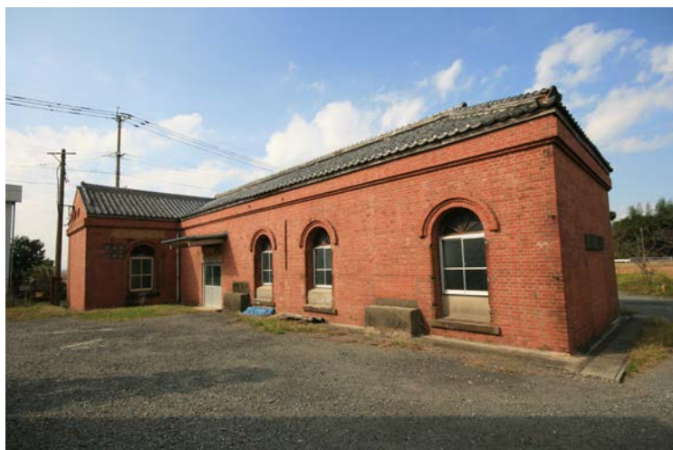
<三井寺ポンプ場>
