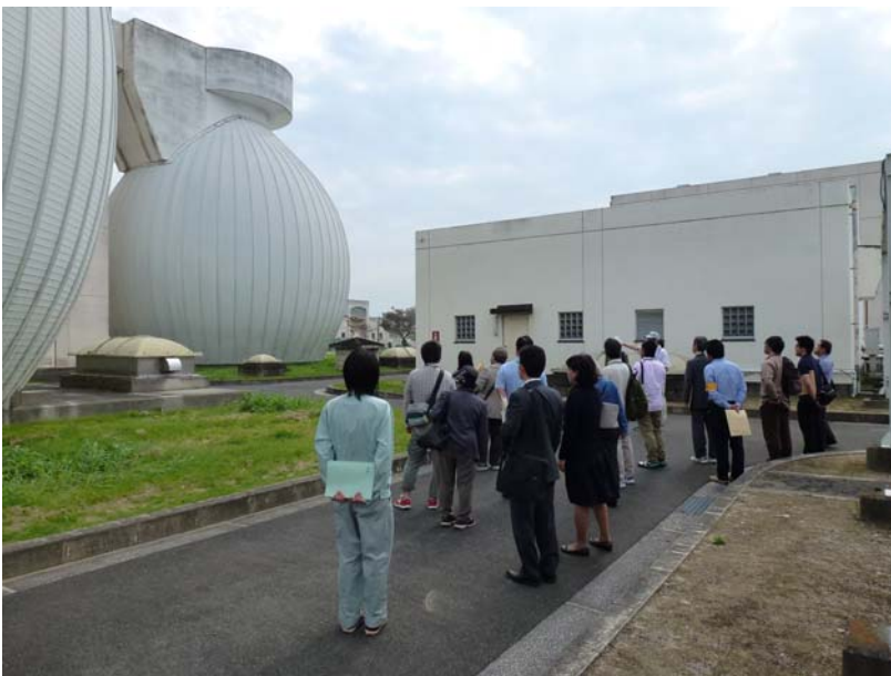
施設見学会で南部浄化センターの バイオマス発電設備を見学している様子
